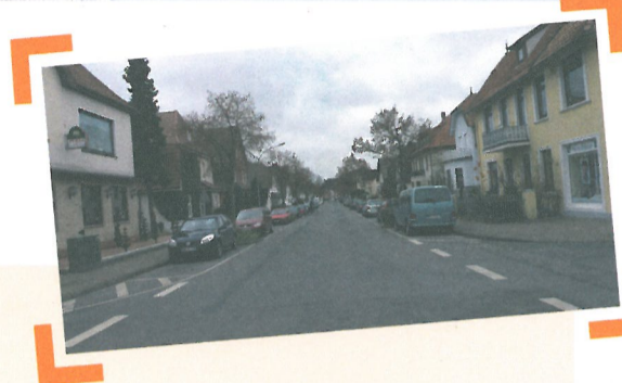
Im Zuge der Sanierungsmaßnahme „Innenstadt Süd“ soll die Bahnhofstraße aufgewertet werden
